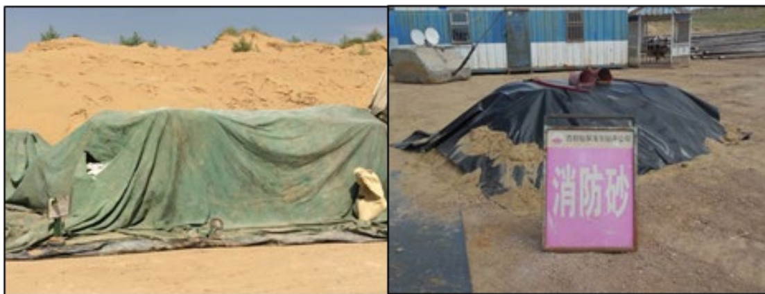
油田常用钻井井场防尘布遮盖示例
