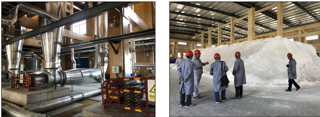
图 4.16 新疆富丽达纤维有限公司蒸发脱盐设施
