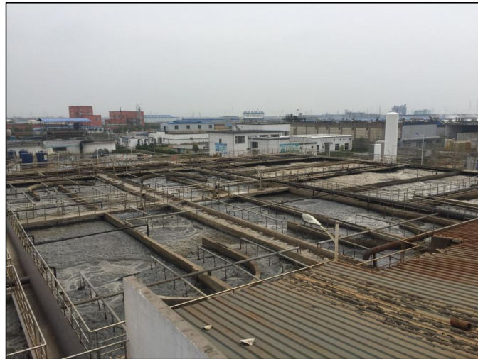
图 3.44 江苏联发印染有限公司废水处理厂处理设施
