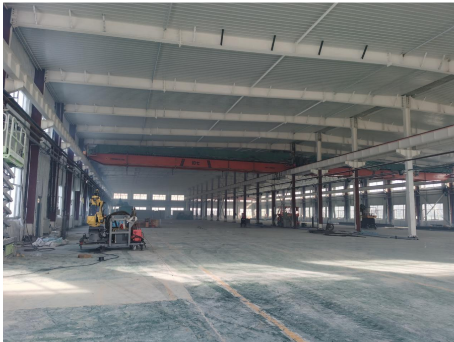
照片1 辐照室拟建场所绿色建筑布电线厂房内环境
