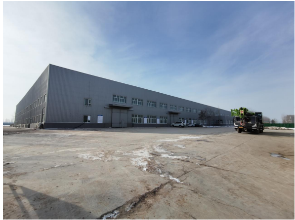
照片 4 拟建场所南侧能源装备电缆车间
