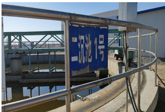
现有污水处理厂沉淀池
