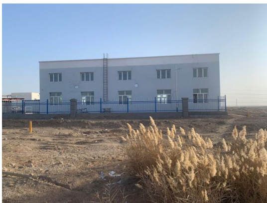
拟建项目北侧现有污水处理厂
