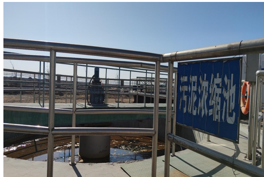
现有污水处理厂污泥浓缩池
