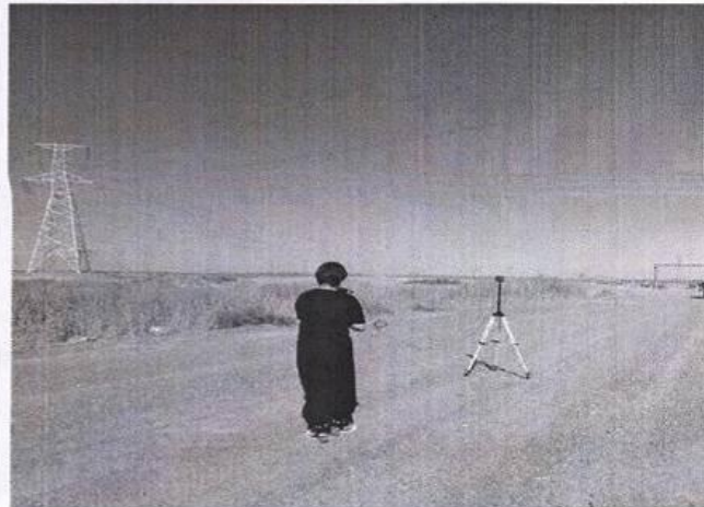
银钛 I 回 220kV 输变电线路线下(单回路)
