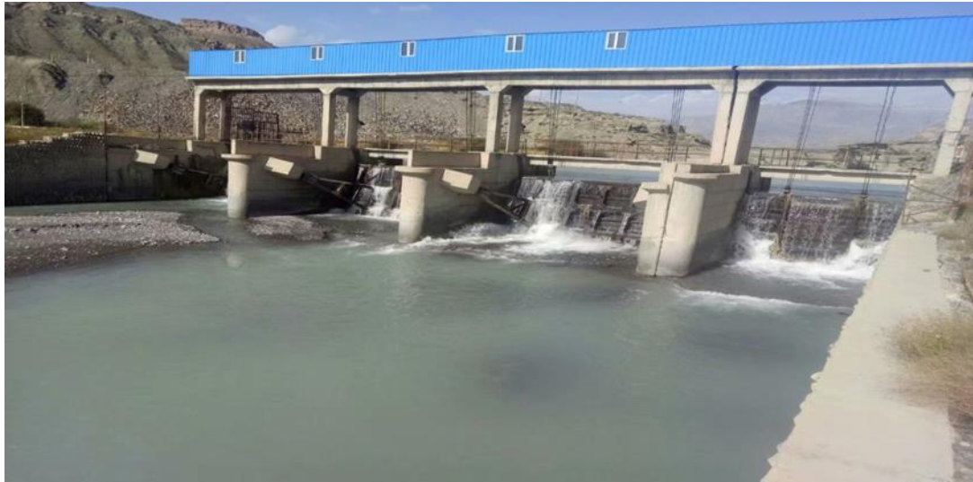
图 3.1-2 库车河北山焦电公司水电站引水枢纽（谷库尔曼水电站引水枢纽） 拦河闸现状
