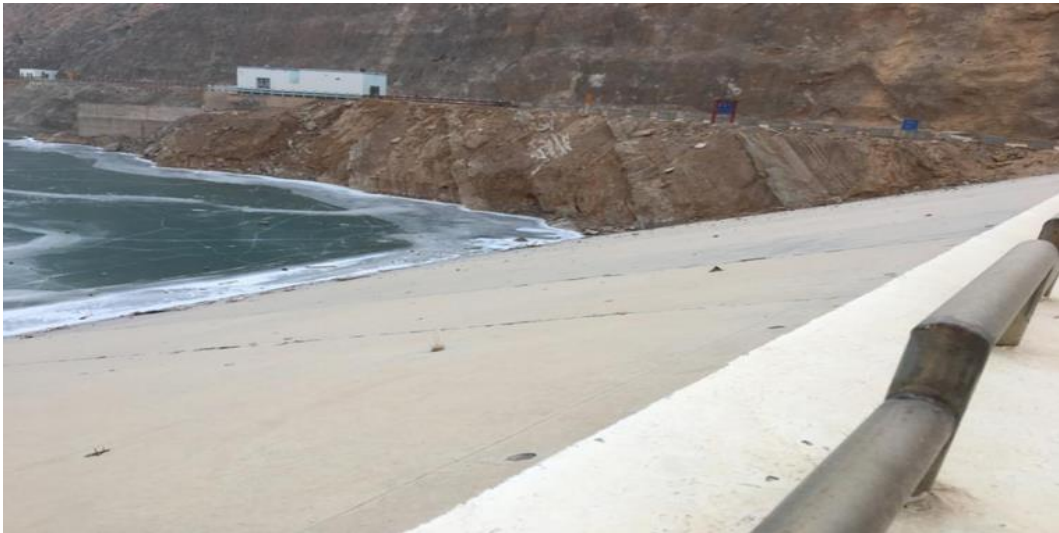
图 3.1-4 铜场水库上游坝坡现状
