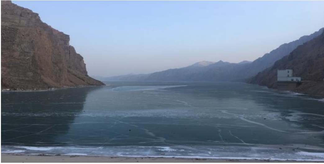
图 3.1-3 铜场水库库区现状
