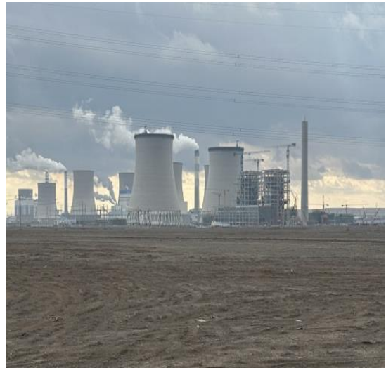
厂区西侧在建电厂
