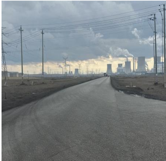
厂区南侧道路
