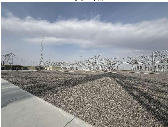
本期主变扩建位置
