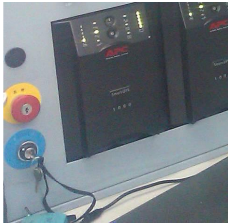
图 10.2.2 系统控制台上安全联锁开关
