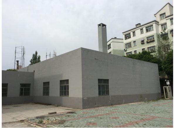
照片 2 项目所在地北侧（小钴源室）
