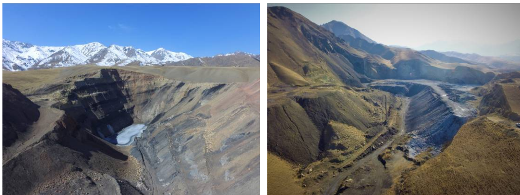
K47+310 利用废弃矿坑弃渣场照片
