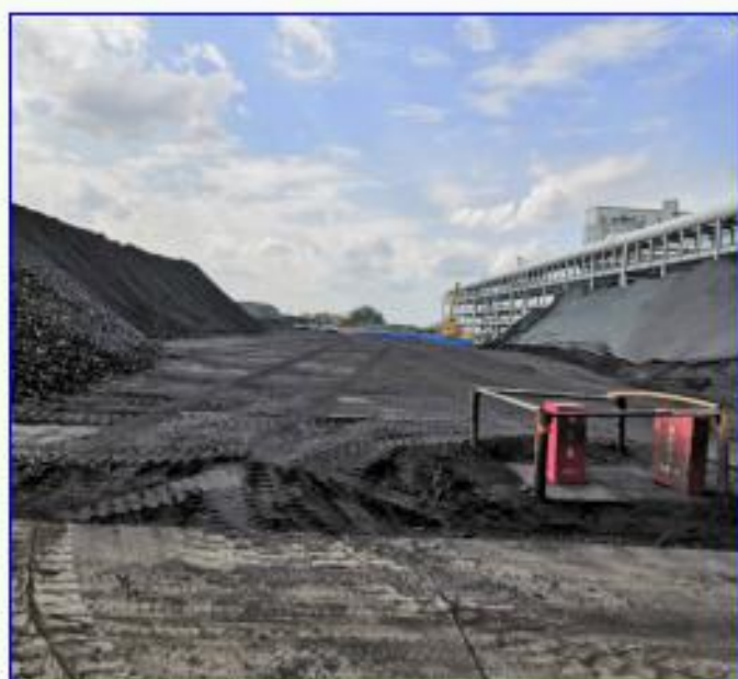
露天煤场(拟改造为罐区和装卸区)
