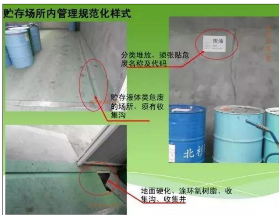
图 9.2-2 地面导流及收集槽样式
