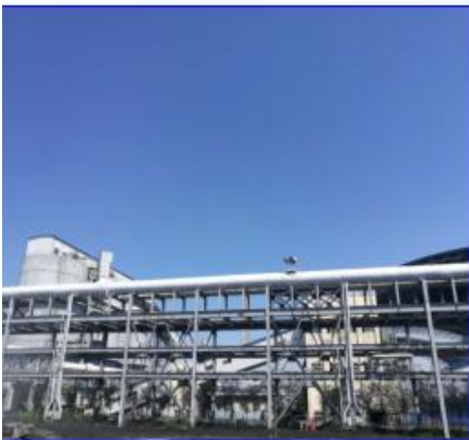
甲醇成品罐区北侧输煤栈桥
