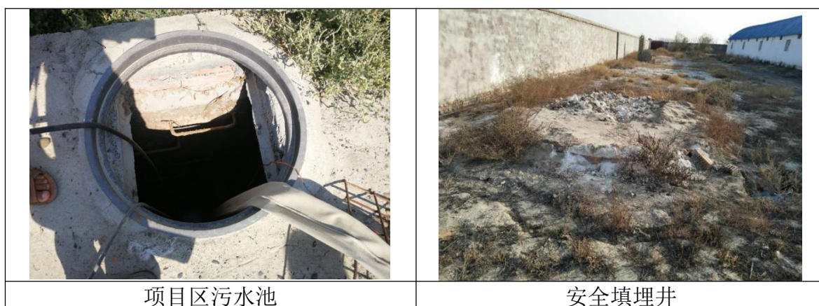
图 3.2-2 本项目污水池及填埋井
