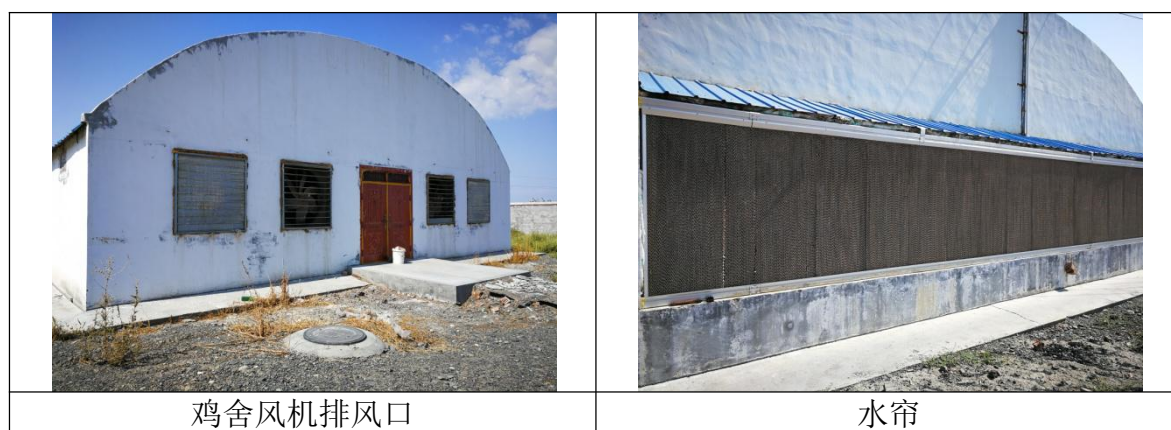
图 3.1-2 项目主要设备现场实景图
