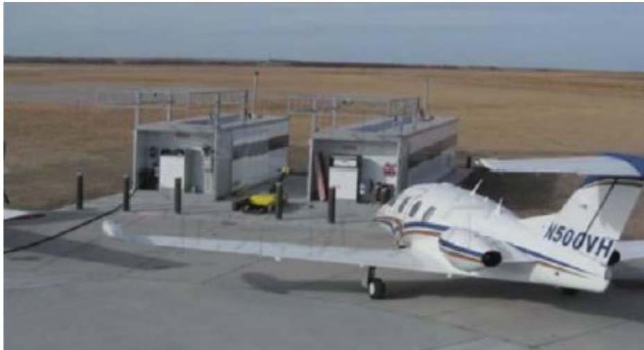
图 3.1-2 撬装式加油站加油示意图
