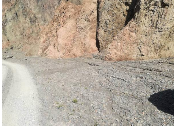
施工生产生活区 (2)
