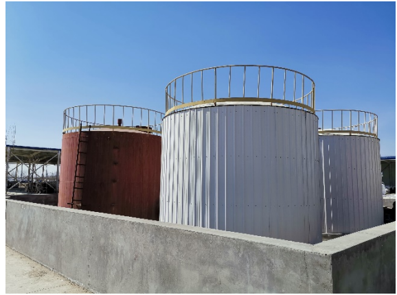
拟拆除储罐区
