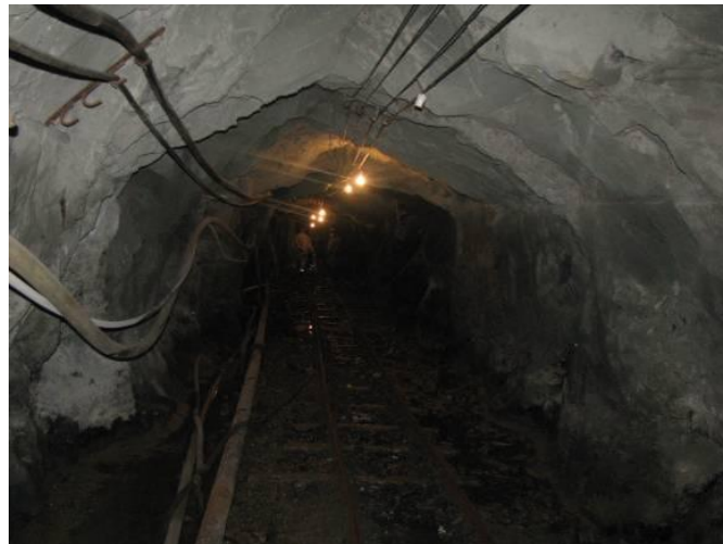
1145m 中段主运输巷（喷砼支护）
