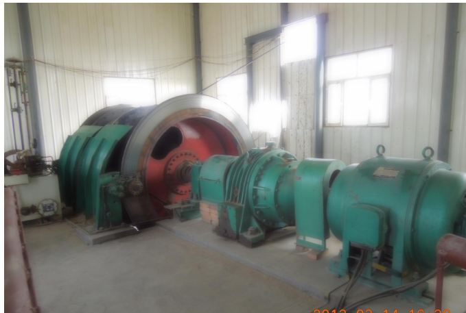
主井安装的提升机
