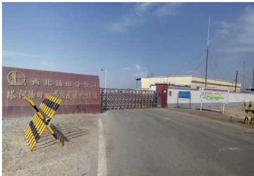
塔河油田一号固废液站
