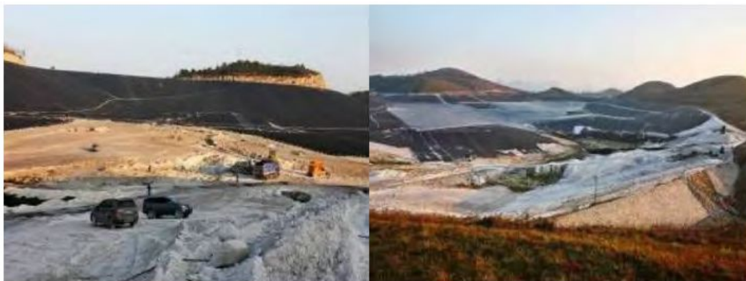
图 6.4-1 同类项目 HDPE 防渗膜现场施工照片
